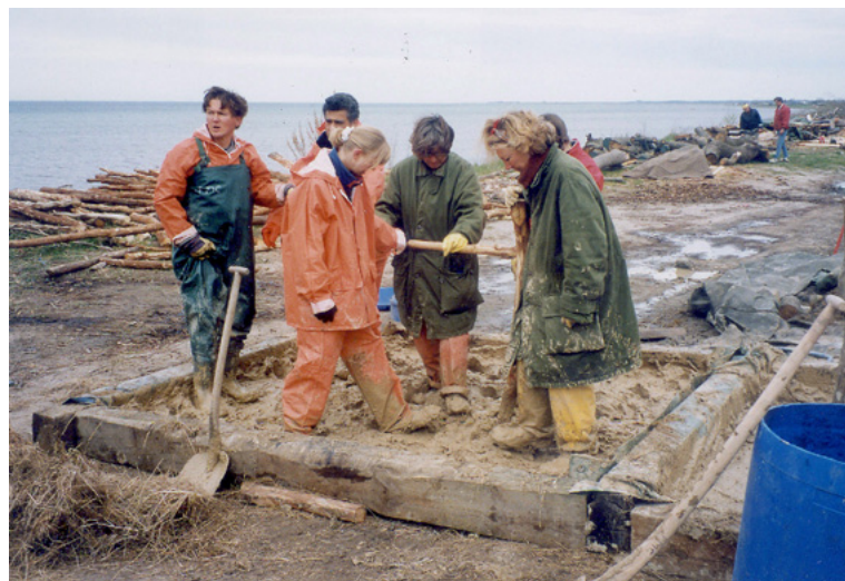
Vid arbetet med lerklining av husen användes många vil-liga fötter för att trampa den tunga leran.
