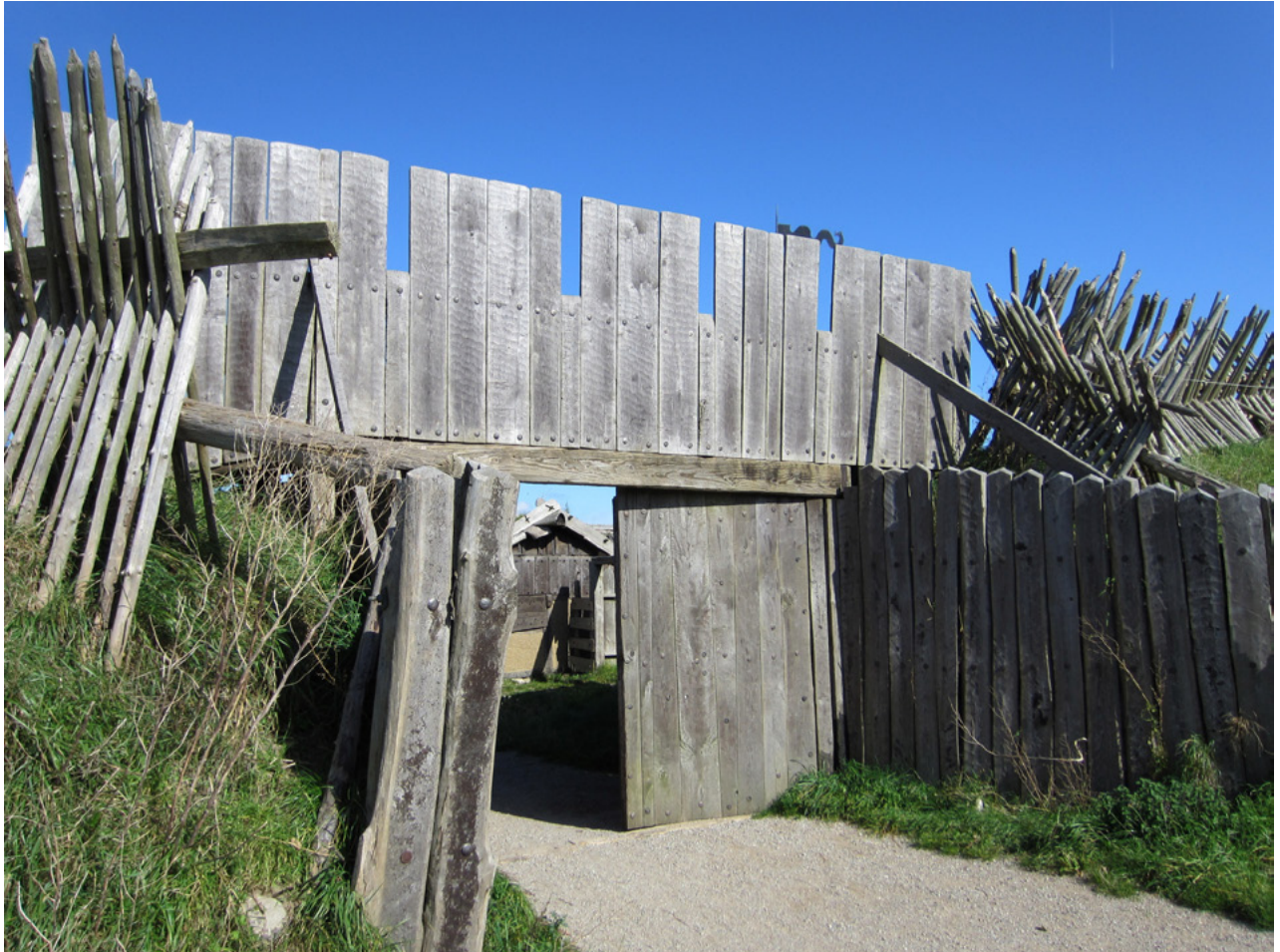
Syndreport i Vikingastaden. Träbarriären över porten har långsmala skjutöppningar, vars form är anpassade för bågskyttar. Till porten ansluter vallens svårforcerade trögärde.
