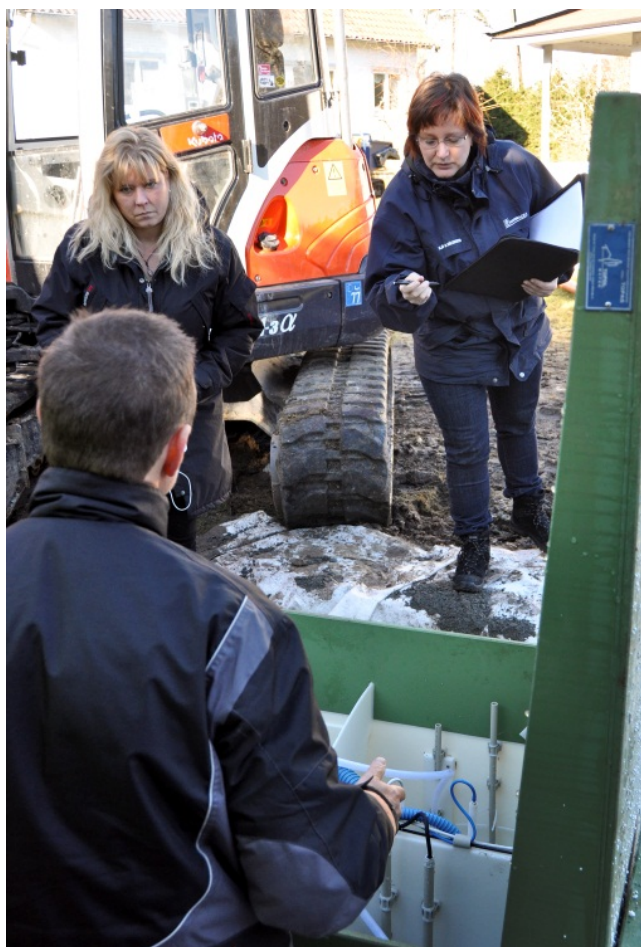
Tillsynsbesök i samband med installation av minireningsverk. Foto: Kungsbacka kommun.
