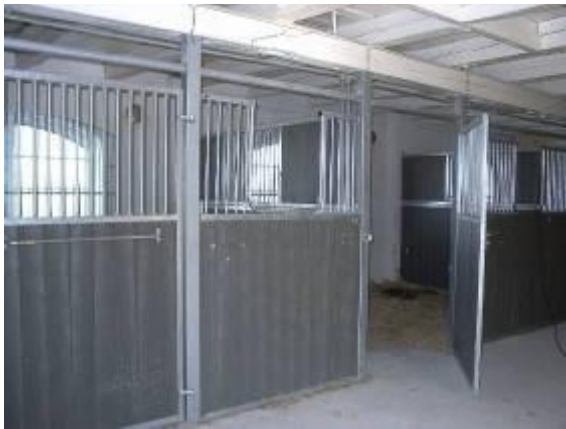
Figur 38. Plastplanken (t.v.) som utfyllnad i boxväggars stålramar kommer starkt på marknaden, även om trä ger ett mer genuin intryck i exempelvis äldre (K-märkta) stall (t.h.).
