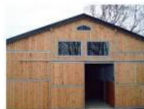
Figur 9. Utestall som används som uteboxstall är acceptabelt. Men tyvärr stängs oftast fönstren vintertid och då blir det en dålig lösning, nämligen ett slutet, otillräckligt ventilerat kallstall. Lärkträ i väggarna är dock ett trädslag som används alltmer, ett prisvärt men mjukt trädslag som tål både väta och som tycks minska risken för att hästarna gnager på träet. [Foto JABA]
