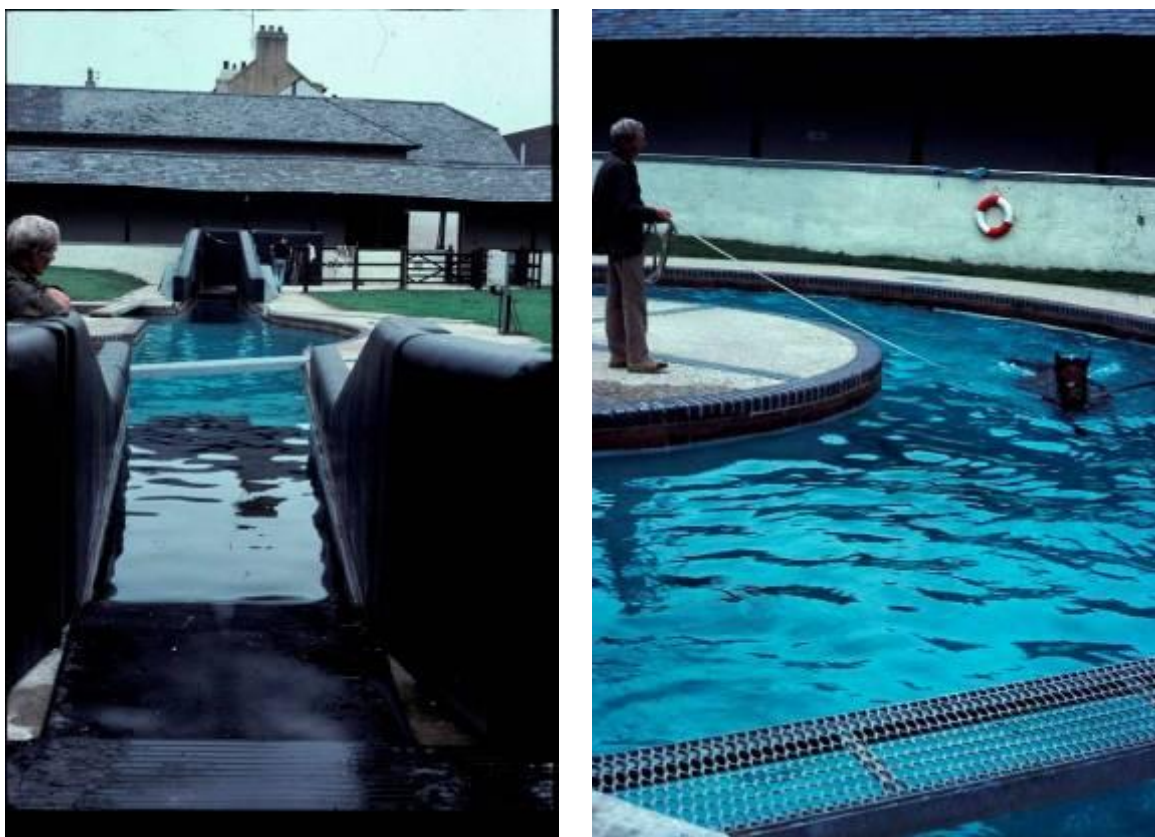
Figur 34. Cirkelformad simbassäng för konvalescenshästar. Bassängens väggar är konkava för att minska risken för att hästen sparkar i väggen och skadar sig.
