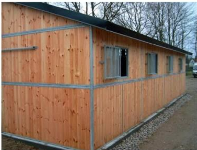
Figur 9. Utestall som används som uteboxstall är acceptabelt. Men tyvärr stängs oftast fönstren vintertid och då blir det en dålig lösning, nämligen ett slutet, otillräckligt ventilerat kallstall. Lärkträ i väggarna är dock ett trädslag som används alltmer, ett prisvärt men mjukt trädslag som tål både väta och som tycks minska risken för att hästarna gnager på träet. [Foto JABA]
