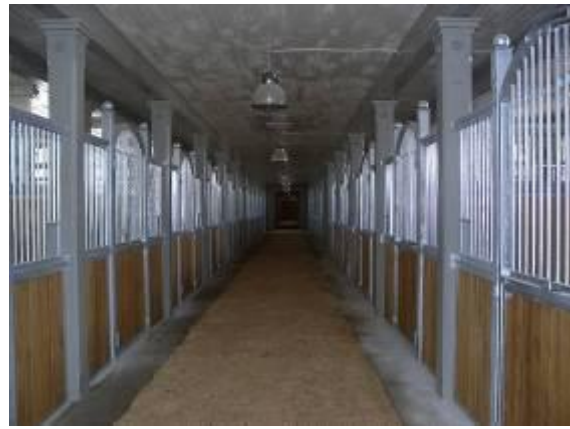
Figur 38. Plastplanken (t.v.) som utfyllnad i boxväggars stålramar kommer starkt på marknaden, även om trä ger ett mer genuin intryck i exempelvis äldre (K-märkta) stall (t.h.).
