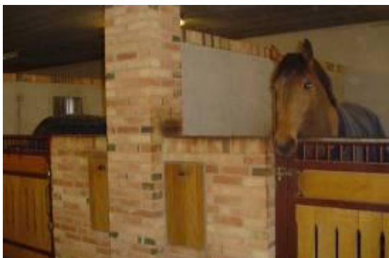
Figur 40. Framför allt murade väggar i tegel kräver lågt underhåll och är beständigt. Putsade murar av lättklinker-, betonghåls- eller skalblock är också använda. Vid önskemål av kulör på putsen är det en fördel om putsen är infärgad för att färgen inte ska skavas av då till exempel hästen rullar sig och skaver med hovarna mot boxväggarna. Även kvarsittande skalelement av betong och massiva betongelement används.
