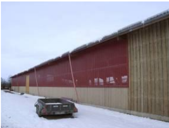
Figur 28. Ridhus med perforerad plåt i väggar ovan ridhussarg. Den perforerade plåten ger tillsammans med taket lä, skugga och skydd för snö och regn och samtidigt mycket av frisk luft och diffust ljus. Takbeklädnaden är på fotot fibercementplattor (utöver den transparenta plastlanterninen) som andas och ger kondensskydd. Genomsikten genom plåten från insidan är besläende trots att öppningsandelen är enbart ca 30 %. [Foto Michael Ventorp]
