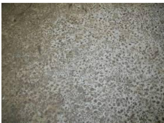
Figur 47. Närbild av ibland förekommande cementslammad HA-betong.
