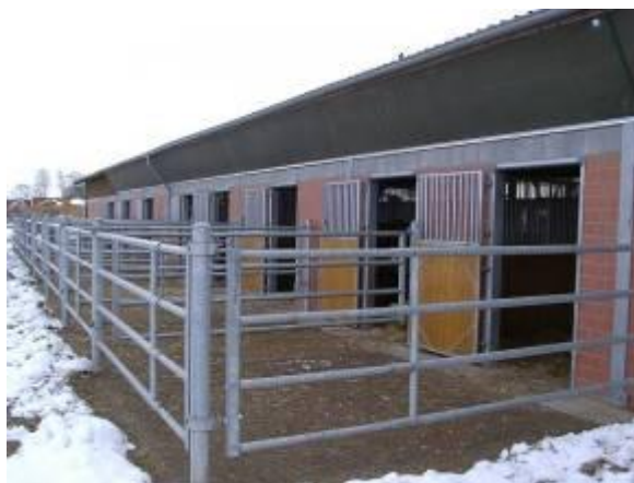
Figur 10. ”Paddockboxar”, alltså en box med en liten paddock utanför boxdörren. I detta tvåradiga boxstall för inackorderad kunde man dessutom plocka bort boxinredningen och göra en ligghall med många mindre öppningar av stallet. Vid stallets gavel fanns en del som var använd som ligghall och kopplat till hagar med datorstyrda foderstationer. Man hade därmed byggt in flexibilitet beroende på kundens önskemål. Observera den stora vindnåts-täckta ventilationsöppningen längs med takfoten. [Foto Michael Ventorp]
