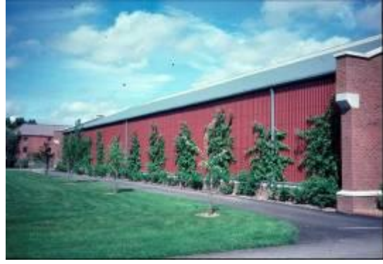
Figur 27. Ett stort ridhus med tung gavel som dock genom det transparenta gavelspetspartiet skapar ett visst sken av två byggnader med två parallella gavelfasader. Långfasaden har byggts i lättare material och förses med spaljé för päronträd. [Foto Michael Ventorp]
