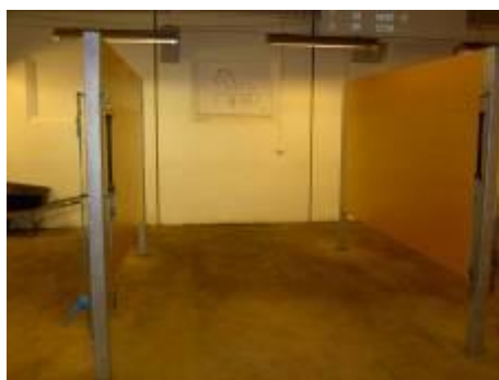
Figur 33. Hovslageri (ljusblått i planlösning) i stall på en lantbruksskola. Det är inte fråga om en smedja för varmskoning med fast ässja, utan en kombinerat lokal med skötselpiltor och förspänning av körhäst (trav). Spiltmellanväggarna i hovslagardelen slutar innan yttervägg och en bit från golvet för att möjliggöra flykt om en häst blir mycket orolig ("får spel"). Många gånger fördrar hovslagare enbart en kraftig bygel i stället för skivvägg eftersom gör det lättare att fly undan (genom att krypa under. Den långa korridoren (mörkgrå) är tänkt som löpgång.
