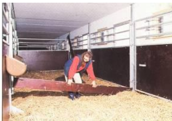
Figur 42. Ett sätt att underlätta utgödning med maskin är att ha svängbara mellanväggar. Det förutsätter dock att man kommer åt med maskinen från boxradens ända och helst att boxen är bredare än djup.
