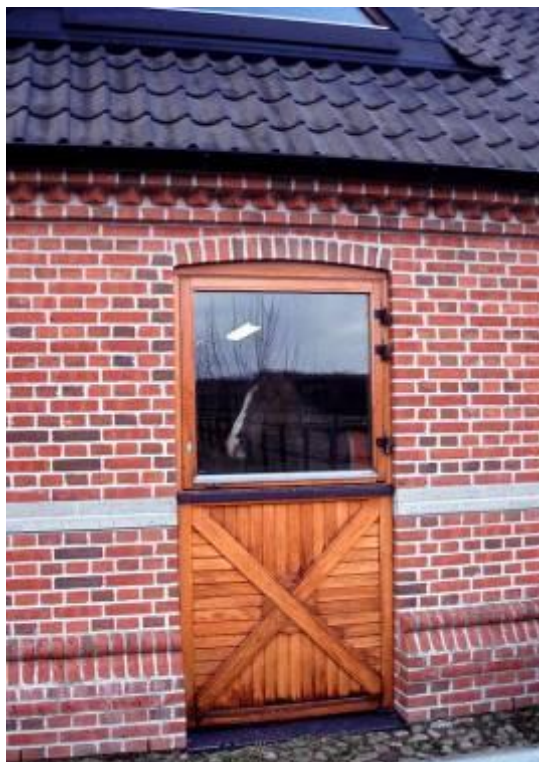
Figur 48. Fönster utan galler men med rätt dimensionerat säkerhetsglas eller motsvarande ger ett trevligt intryck.
