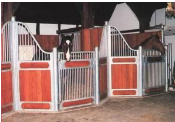
Figur 41. "Burspråksfront" är en "ny" form på boxfronter som ger en god överblick för hästen. I ritningen till höger har man nyttjat boxfrontens veck för ett specialdesignat skåp för att till exempel hänga täcken i. "Renhållningslinjen" blir därmed rak – det är annars besvärligt att sopa och hålla hörnen mellan den utskjutande delen av fronten ren.
