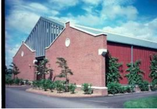
Figur 27. Ett stort ridhus med tung gavel som dock genom det transparenta gavelspetspartiet skapar ett visst sken av två byggnader med två parallella gavelfasader. Långfasaden har byggts i lättare material och förses med spaljé för päronträd. [Foto Michael Ventorp]
