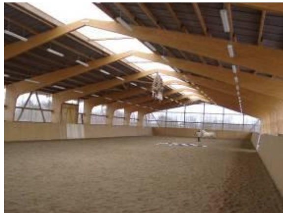
Figur 28. Ridhus med perforerad plåt i väggar ovan ridhussarg. Den perforerade plåten ger tillsammans med taket lä, skugga och skydd för snö och regn och samtidigt mycket av frisk luft och diffust ljus. Takbeklädnaden är på fotot fibercementplattor (utöver den transparenta plastlanterninen) som andas och ger kondensskydd. Genomsikten genom plåten från insidan är besläende trots att öppningsandelen är enbart ca 30 %. [Foto Michael Ventorp]
