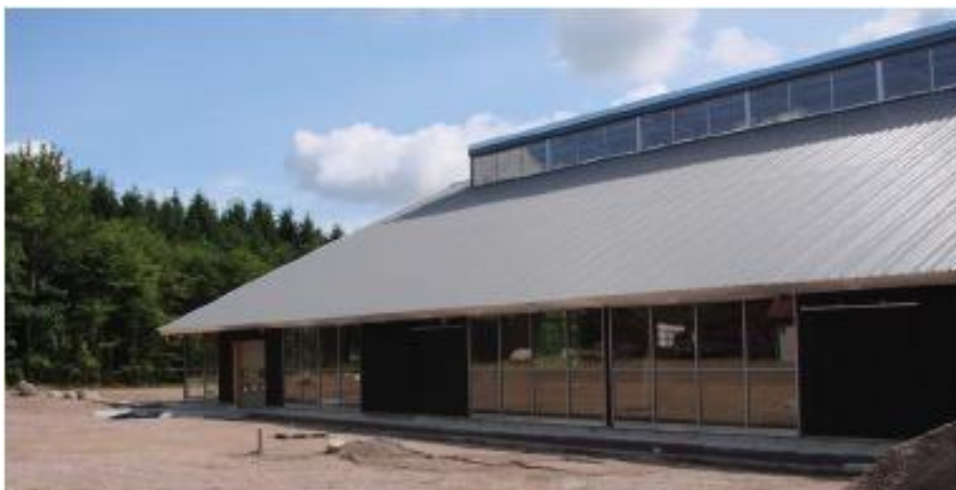
Figur 26. Ridhus som är nedsänkt för att vägghöjden ska bli lägre. Kraftigt takutsprång ger både skugga och utvändigt en mindre byggnadsvolym.
