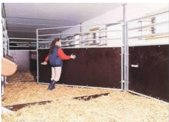
Figur 42. Ett sätt att underlätta utgödning med maskin är att ha svängbara mellanväggar. Det förutsätter dock att man kommer åt med maskinen från boxradens ända och helst att boxen är bredare än djup.
