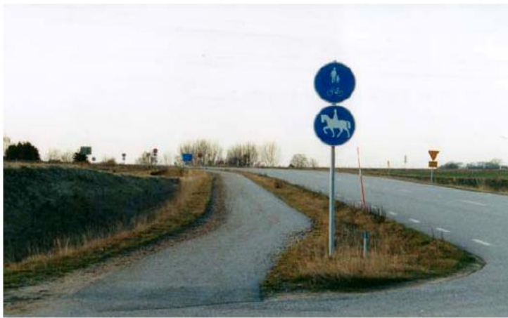
Bild 24. En smal ridstig vid sidan av cykelvägen är ett utmärkt sätt att öka tillgängligheten och säkerheten för ridande, vägen kan dock utformas något annorlunda och då bli både tryggare och mindre konfliktskapande. Hästarna blir ett trevligt inslag i landskapet, istället för en fara och ett irritationsmoment. Foto Hanna Persson
