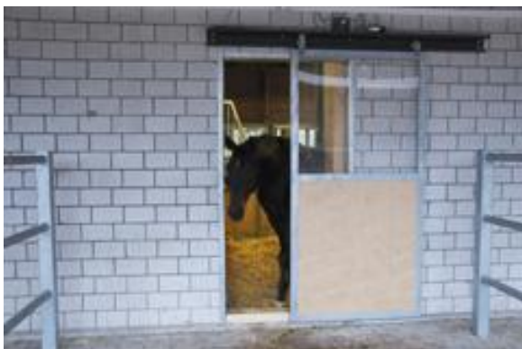
Figur 11. Den lilla individuella paddocken kan även anslutas till ett traditionellt inneboxstall. För att spara värme har man här försett dörren med automatisk öppning och stängning när hästen vill in respektive ut.
