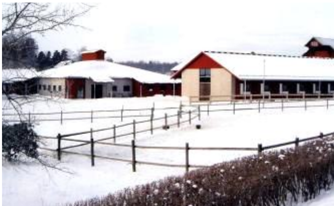
Figur 14. Ett stall på Strömsholms utbildningsanläggning. Här har man separerat stall och serviceavdelning i skilda byggnader. Färgfotot är på färdiga byggnader, medan det sv/v fotot samt skisser är förslagshandlingar. Servicegången är ursprungligen ämnad att enbart användas vid utfodring och daglig utgödsling. Portar i yttervägg i varje box är
